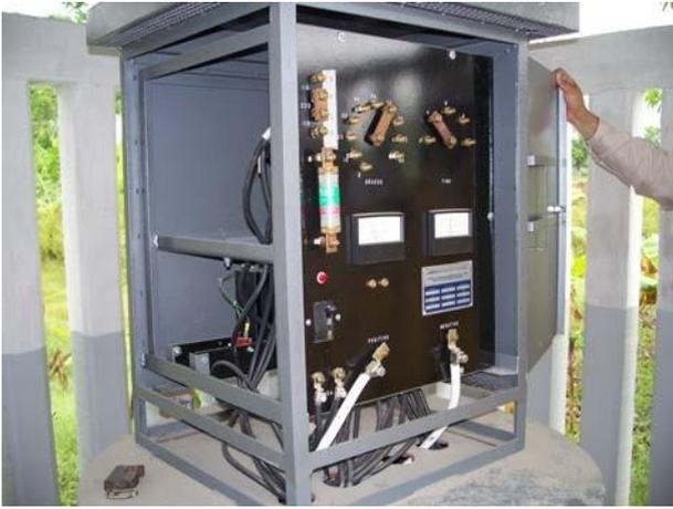
断路器一端装有大型散热器，用来为金属氧化物半导体场效应晶体管（MOSFETS）降温。散热器一般不会发烫，但在高电阻率土壤中控制100伏5安培的变压器整流器时，我们发现散热器温度有所升高；当时是中午，周围温度为30°C。
